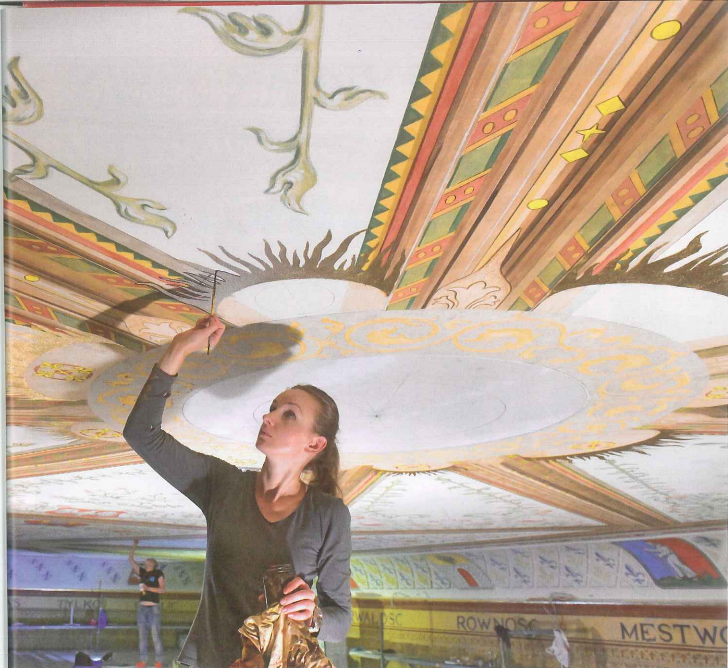
Przy pracy Rita Pietrzak. Na stropie sali gimnastycznej powstają zdobienia, rozeta i belkowanie. Odtwarzanie polichromii trwało siedem miesięcy.
